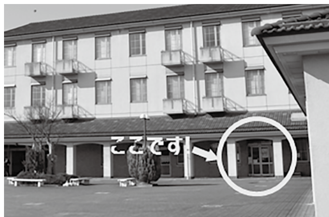
保健室は講義棟入口近くにありますが
